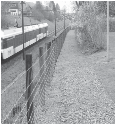
Frisch gesplitteter und verbreiteter Deckbelag
