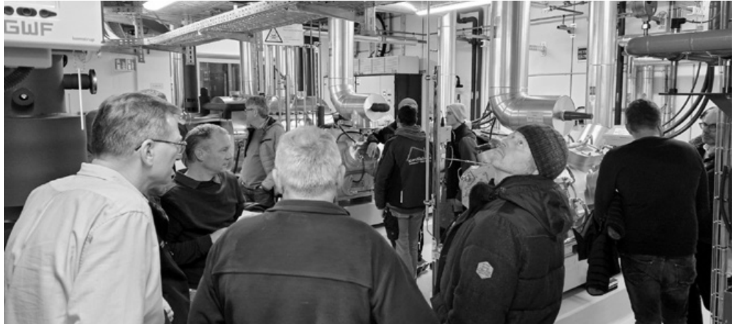
Besucher besichtigen die neu erstellte Wärmezentrale auf dem ARA-Gelände. (Bild: Roger Mauchle)
