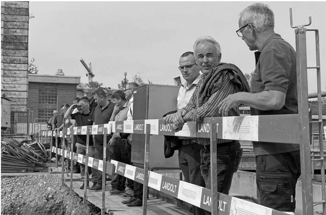
Betriebsleiter Peter Wehrli erläutert Gemeinderat Walter Schindler und Gemeindepräsident Christian Hinterberger (v.r.) den Bau der Wärmezentrale.
