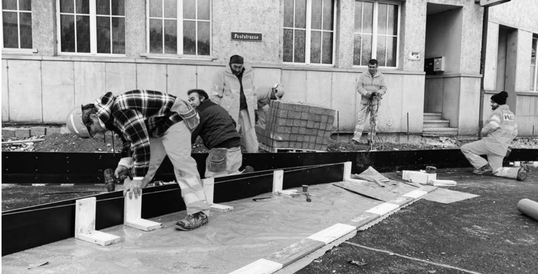
Die Betonierung des Kreisels am Bahnhof muss gut vorbereitet sein. (Foto tw)
