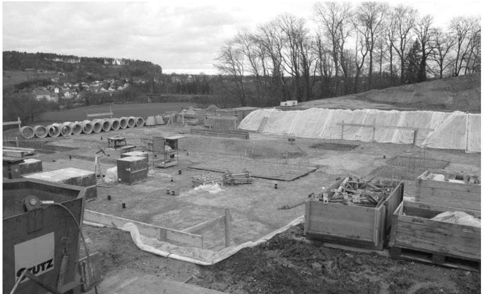
Bauphase – Stand Dezember 2009 – Einlegearbeiten für das Projekt Haus «Am Städeli»
