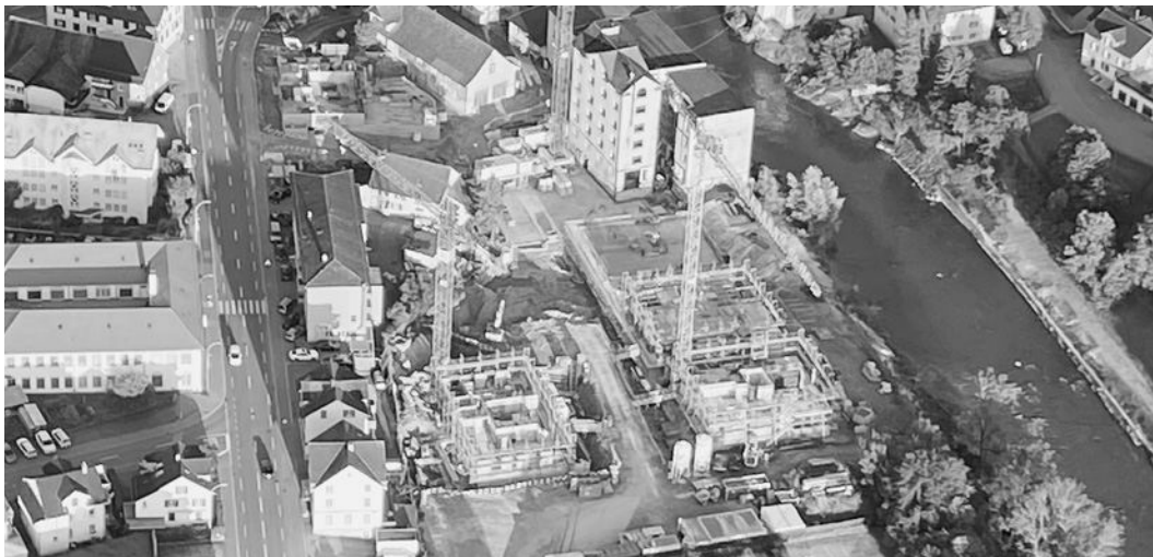
Das Bruggmühleareal 2021 im Bau.
