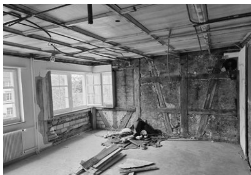
Vor der Sanierung wird die Bausubstanz gründlich untersucht.
