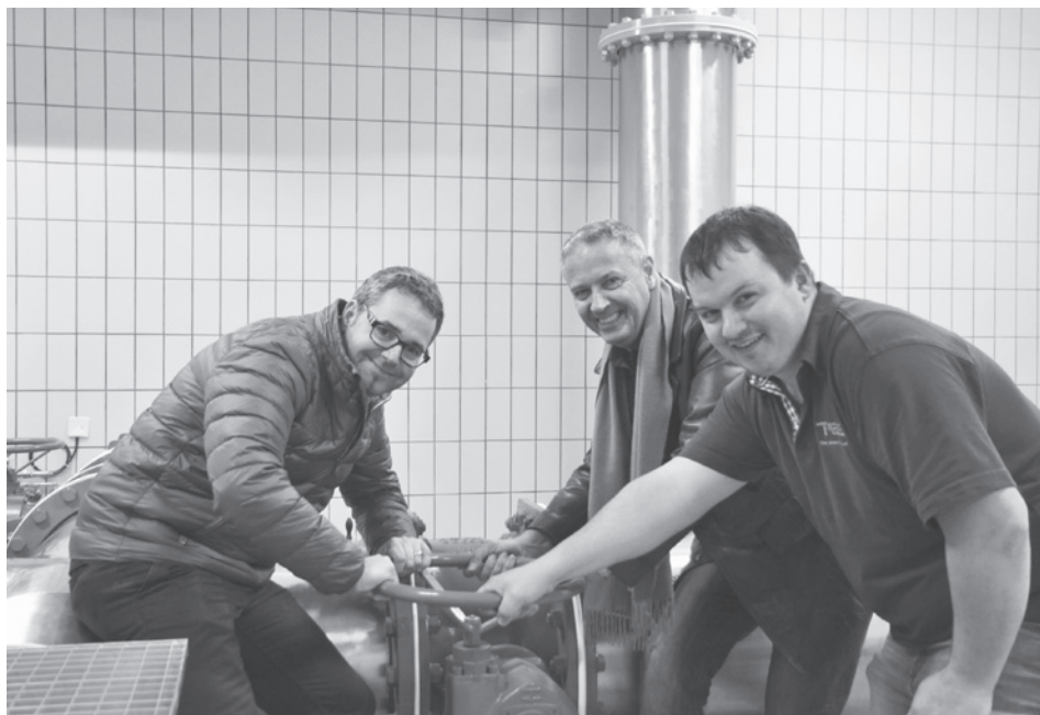
Thomas Weingart, Stadtpräsident von Bischofszell, Thomas Hirt, TGB-Geschäftsleiter, und Ante Jularic, TGB-Bereichsleiter Wasserversorgung, im frisch sanierten Reservoir Freudenberg
