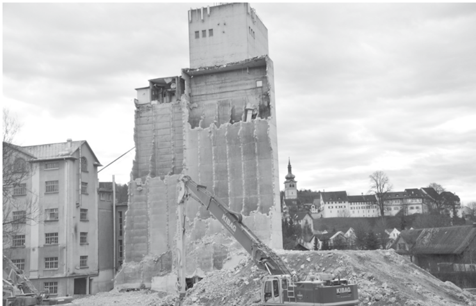
Beginn der Abbruchphase am 14.12.14
