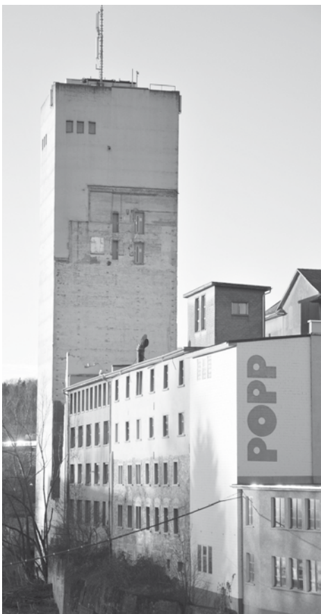
Nackt und allein steht der letzte Finger, der als Standort von Swisscom-Antennen noch stehen bleiben muss. 13.01.15
