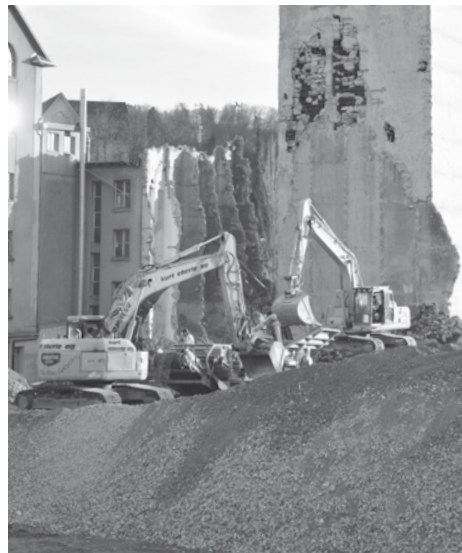
Die Unmenge von Bauschutt muss mit Maschinen verkleinert und abtransportiert werden. 15.01.15
